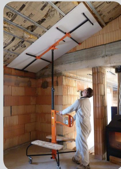
Chargement d'une plaque de 1,20 m x 2,50 m en vue d'une pose sous rampants.
